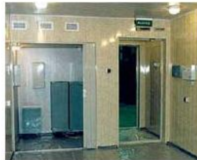
Рисунок 2.9 - Сборно-разборное экранированное сооружение (камера): а) вид снаружи; б) и в) вид внутри в экранированное сооружение для информационного обмена с установленной в нём аппаратурой.
