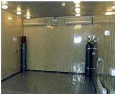
Рисунок 2.9 - Сборно-разборное экранированное сооружение (камера): а) вид снаружи; б) и в) вид внутри в экранированное сооружение для информационного обмена с установленной в нём аппаратурой.
