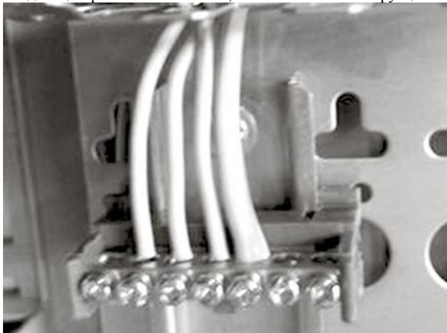
Рисунок 2.12 - Пример присоединения к главной шине заземления заземляющих проводников
