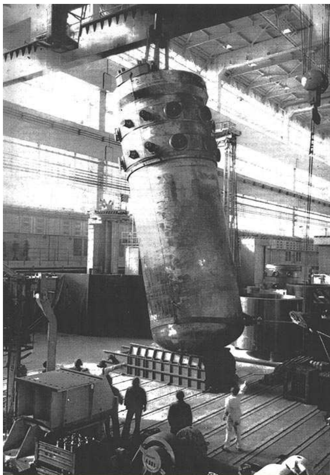
Рис. 5.5. Корпус ядерного реактора ВВЭР-1000
