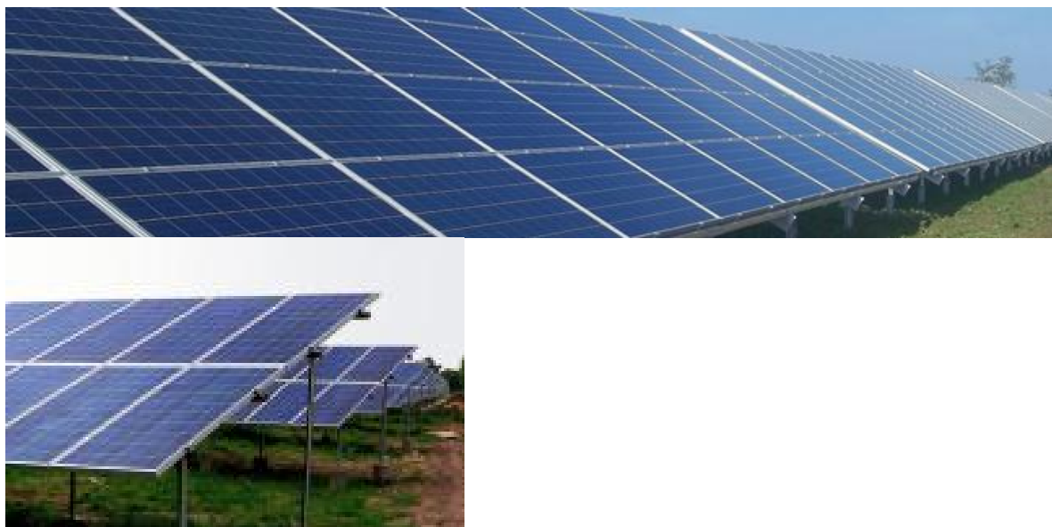
Рис. 2 – Солнечные панели (батареи) на фиксированных опорах
