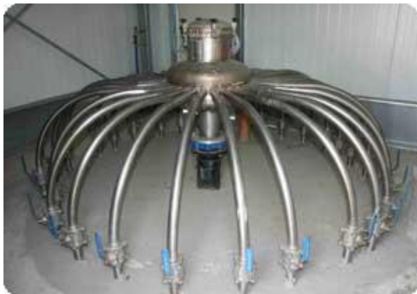
Система гидравлического смешивания
