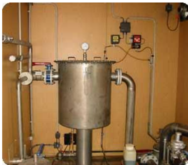
Система очистки биогаза от серы и аммиака
