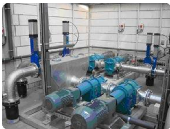
Система подачи разжиженного помета
